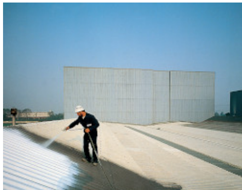
Applicazione di Aquaflex a spruzzo su cemento amianto ondulato trattato con Malech
