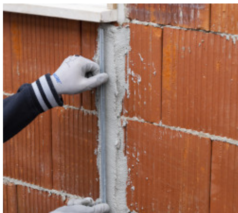
Posizionamento delle guide verticali
