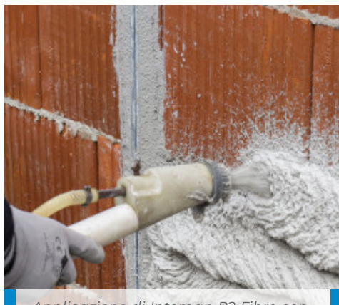
Applicazione di Intomap R2 Fibro con intonacatrice
