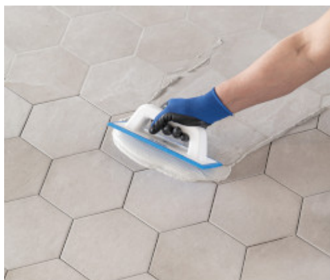
Stesura di Keracolor FF con spatola MAPEI
