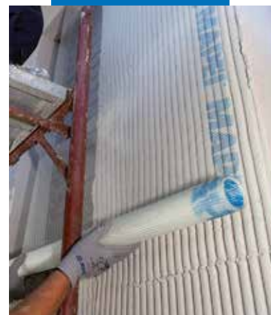
Posa della rete Mapetherm Net nella prima mano di rasante
