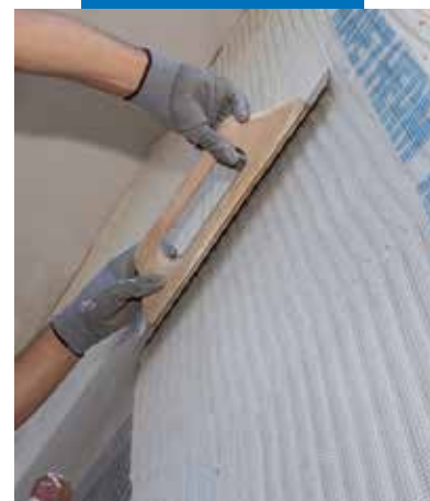
Inserimento della rete d'armatura Mapetherm Net
