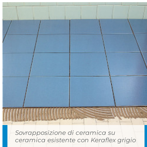
Sovrapposizione di un rivestimento in monocottura su marmette esistenti
