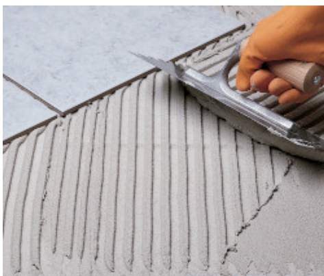
Posa di monocottura su parete in blocchi di cemento cellulare espanso
