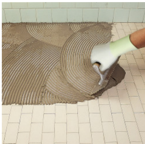
Posa di marmo prelevigato a pavimento
