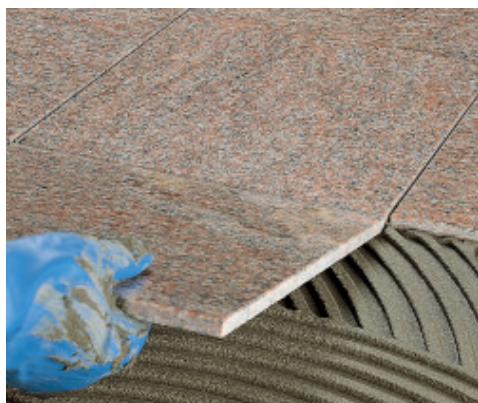
Posa di marmo prelevigato a pavimento
